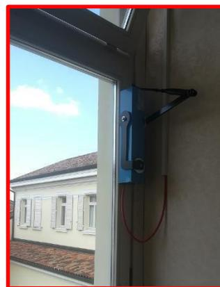
Serramenti motorizzati per l'apertura automatica delle finestre dei vani scale in caso di allarme incendio
