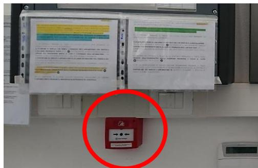
Dispositivo per l'apertura automatica del serramento posto sulla sommità del vano scale centrale
