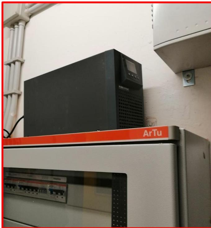
*Dettaglio fotografico pannello di controllo gruppo di continuità (UPS) installato presso il vano tecnico*
