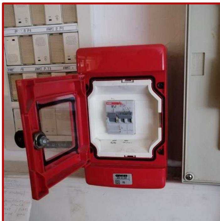
Sblocco d'emergenza sistema controllo accessi
